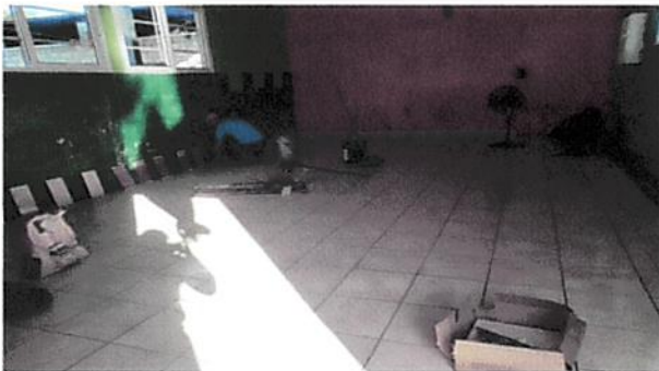
Foto 5: Instalación de piso cerámico.
