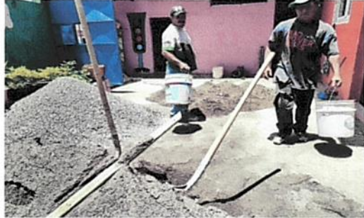
Foto1: Reparación de filtración de paredes existentes.
