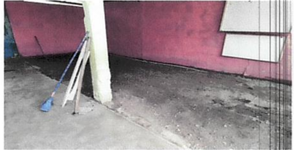
Foto 4: Fundición de concreto de 10 cms.
