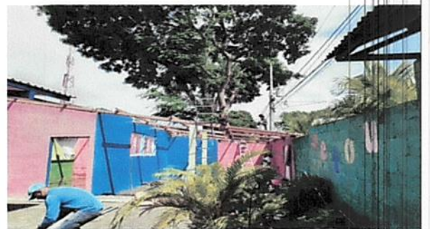
Foto 6: Sustitución de lámina troquelada calibre 26.
