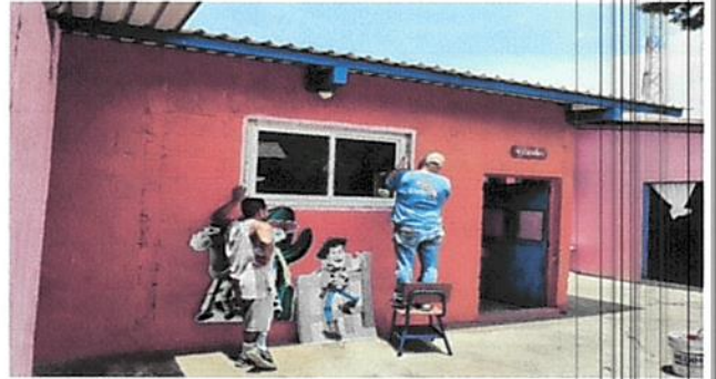
Foto 2: Instalación de ventanas de PVC y sedaso.
