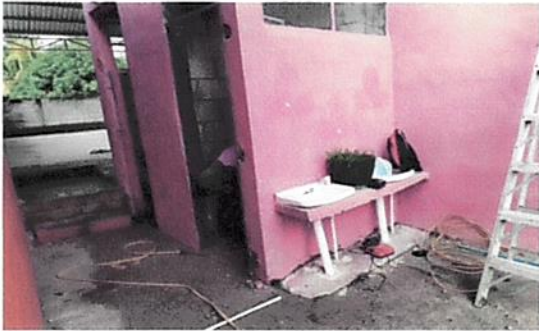
Foto 3: Reparación de puertas de baño.
